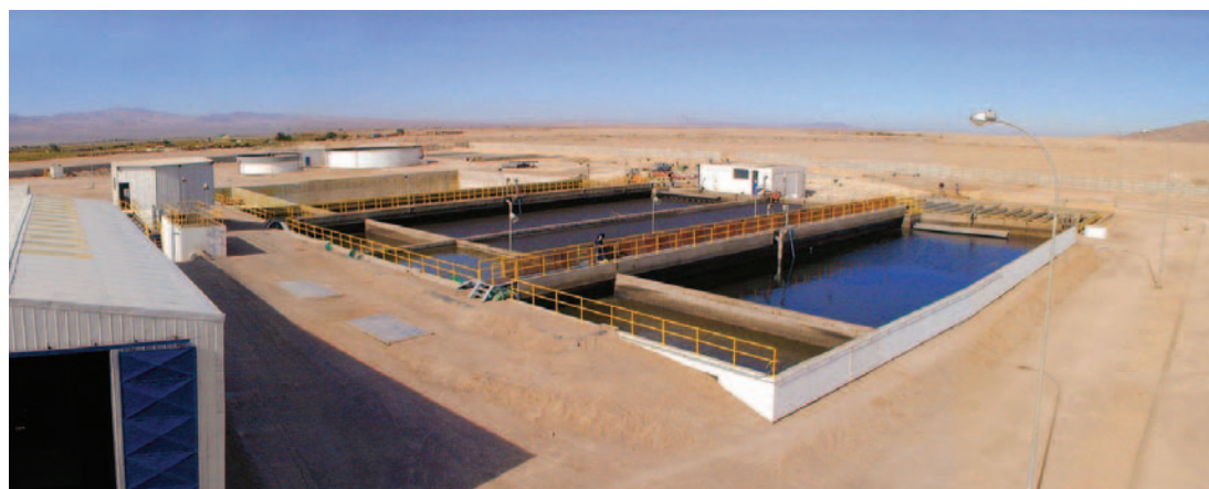
Planta de Filtros Cerro Topater, Calama.
