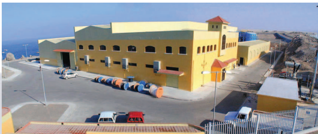
Planta desaladora de Agua Potable, Antofagasta.
